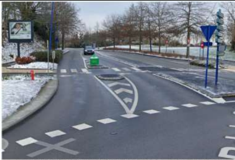
Réalisation d'un îlot refuge sur double voie d'entrée – giratoire à Vannes
